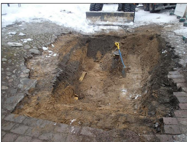
Vasemmallla: Pohjoiseen. Voimakaapelin varoitussauha on tullut esille kaivannon länsireunassa, n. 50 cm syvyydellä. Myös viemäriputken betoninen harja on alkanut pilkottaa valkoisena laikkuna lapiosta n. 50 cm kuvaajaan päin. Oikealla: Pohjoiseen Kaivanto n. 150 cm syvyydellä.
