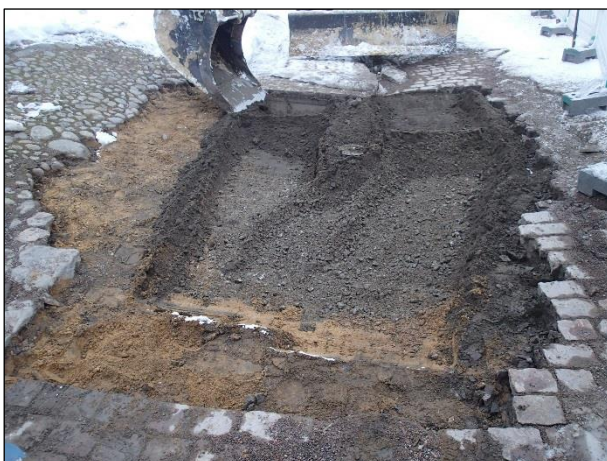
Vasemmallla: Kaivanto 1 n. 20 cm syvyydellä. Ilmeisesti vesijohdon aikaisempien korjaamisien yhteydessä kaivetulla alalla esiintyi harmaata sepelihiekkää. Pohjoiseen. Oikealla: Sepelihiekan alta paljastui vaaleampia täyttökerroksia n. 30 cm syvyydeltä alkaen. Pohjoiseen.
