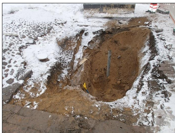
Vasemmallla: Pohjoiseen. Voimakaapelin varoitussauha on tullut esille kaivannon länsireunassa, n. 50 cm syvyydellä. Myös viemäriputken betoninen harja on alkanut pilkottaa valkoisena laikkuna lapiosta n. 50 cm kuvaajaan päin. Oikealla: Pohjoiseen Kaivanto n. 150 cm syvyydellä.
